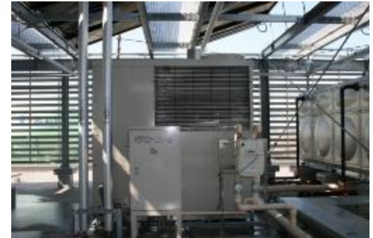
ガスエンジンコージェネ(C.H.P) 系統連係型 25KW
