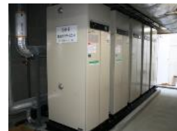
ガス焚き温水ボイラー 233KW * 5基
