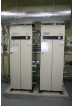
ガス焼き温水ボイラー 198KW * 2
