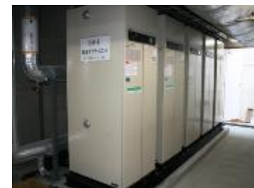
ガス焼き温水ボイラー 233KW * 5基
