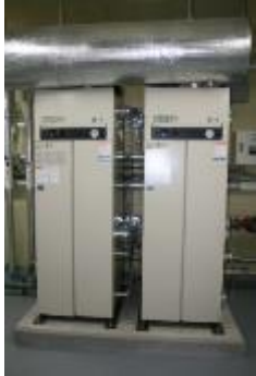
ガス焼き温水ボイラー 198KW * 2
