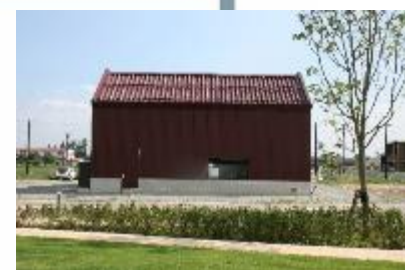
エネルギープラント
