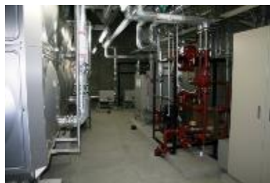
太陽熱回収装置 & 蓄熱タンク60ton
